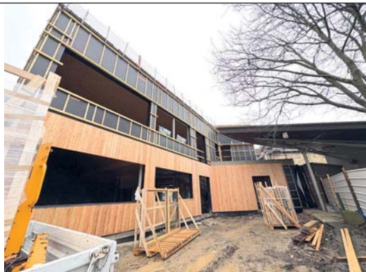
Travaux, le 3 mars
