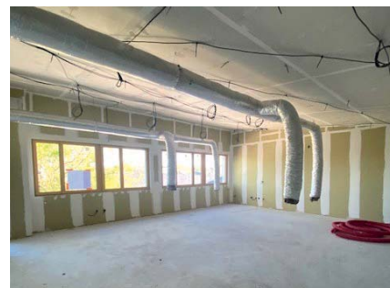
Travaux, le 10 avril
