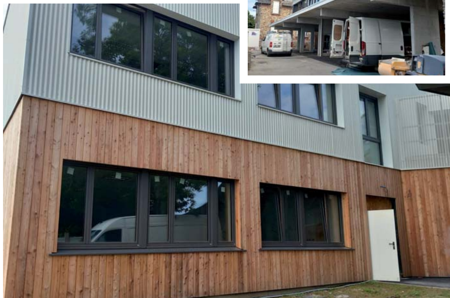
Travaux en cours de finition - Mi-juin.
